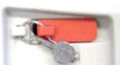
Блокировка включена и опломбирована проволочной пломбой
